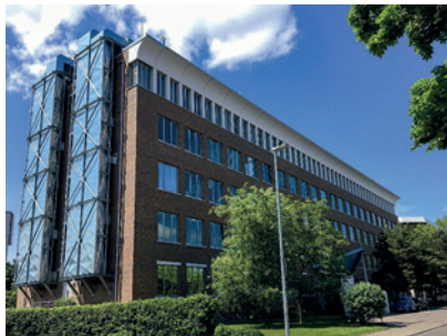
Abbildung 1: BioChem-Labor- und Verwaltungsgebäude (Quelle aller Abbildungen: BioChem).
